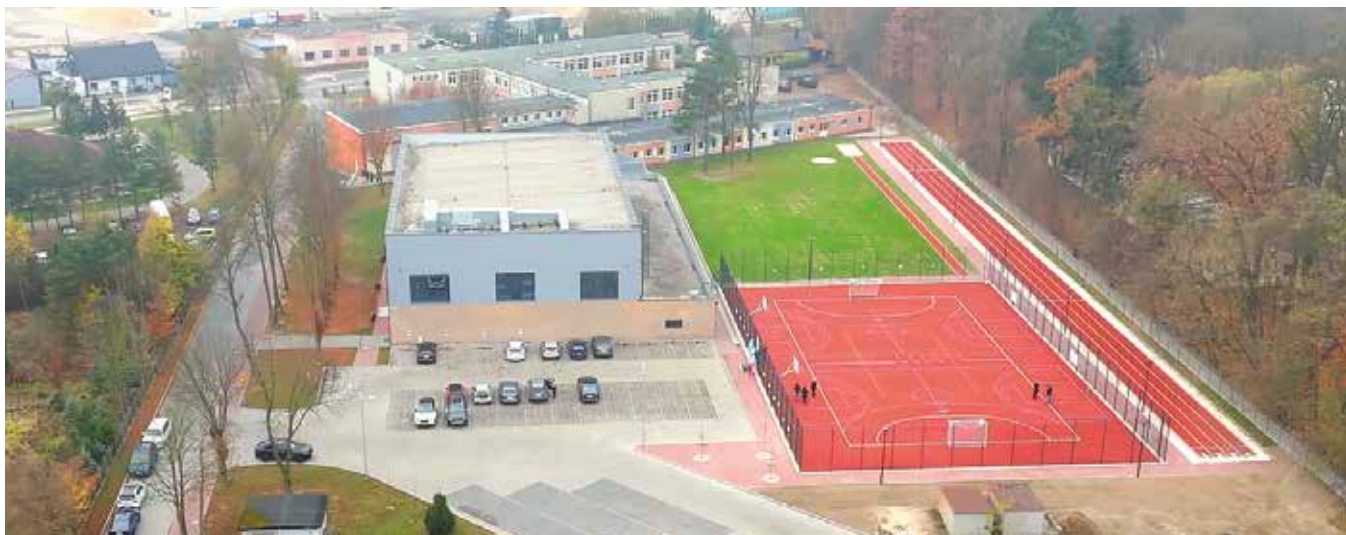
▲ Hala Sportowa Powiatu Kłobuckiego przy Zespole Szkół Nr 1 w Kłobucku oraz wielofunkcyjne boisko
